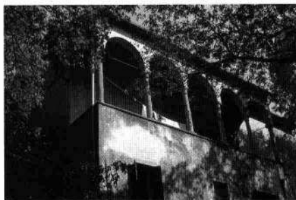
L'angolo nord-occidentale della villa La corte meridionale La trifora della facciata meridionale La loggia occidentale
