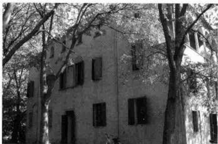
L'interno del portico a oriente della corte La torre colombara a sud della corte Il portico a oriente della corte Il fronte settentrionale
