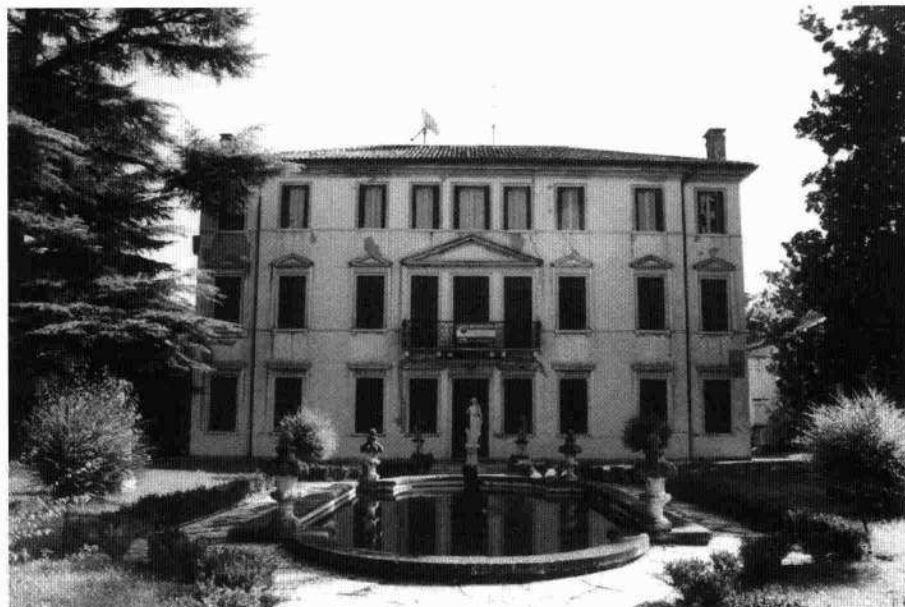
Veduta del retro della villa con i collegamenti laterali (Archivio IRVV) La facciata principale della villa (L.S. 1998)
