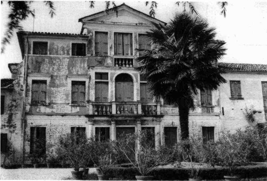
Il fronte principale prima dei restauri (Archivio IRVV)
