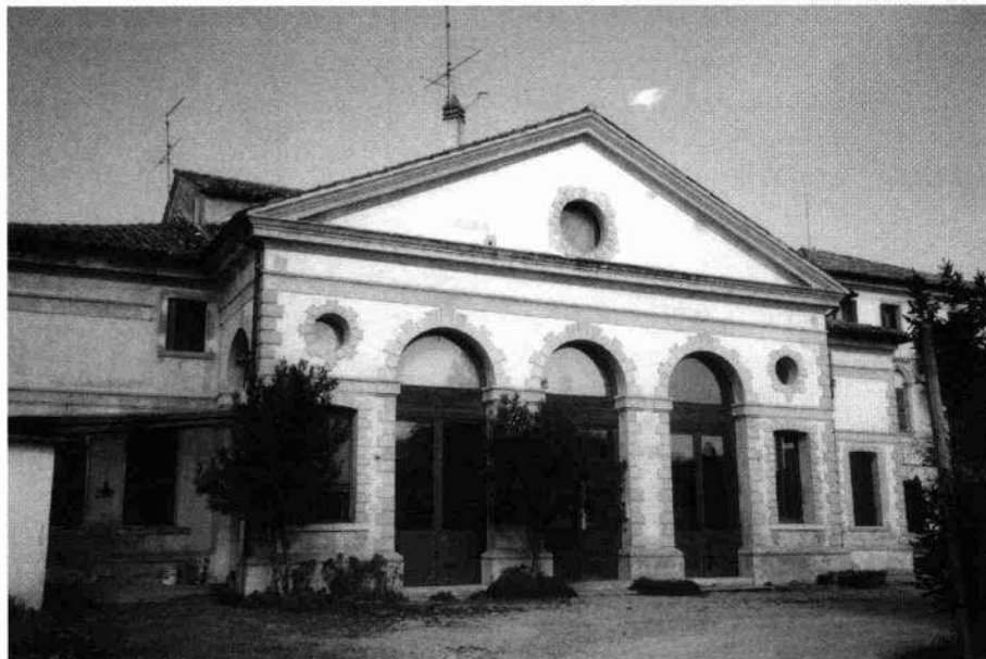
Veduta del fronte laterale nord-ovest da cui prende luce il vano scala (Archivio IRVV) La facciata della vicina barchessa (Archivio IRVV)
