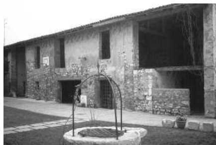
Vista del corpo padronale dal cancello d'ingresso (Archivio IRVV)
