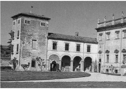
L'antica torre colombara cinquecentesca e l'ala rustica porticata (Archivio IRVV) Particolare del fronte principale (Archivio IRVV)
