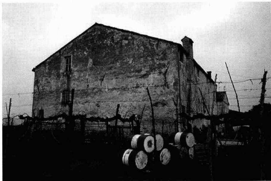
Particolare del portale di ingresso Il fianco ovest della villa
