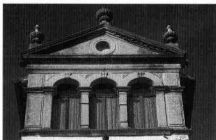
Fronte principale: particolare: il timpano (A. Dalla Caneva, 2003)
