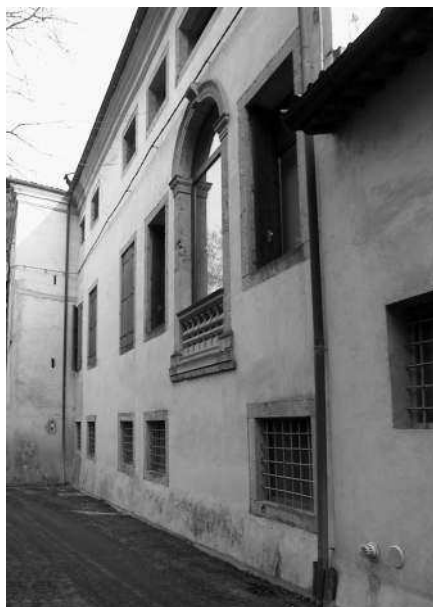
Prospetto posteriore (C.B.) Particolare del corpo centrale (C.B.)
