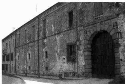
Particolare del portale d'accesso alle adiacenze Le adiacenze a nord Particolare delle adiacenze settentrionali
