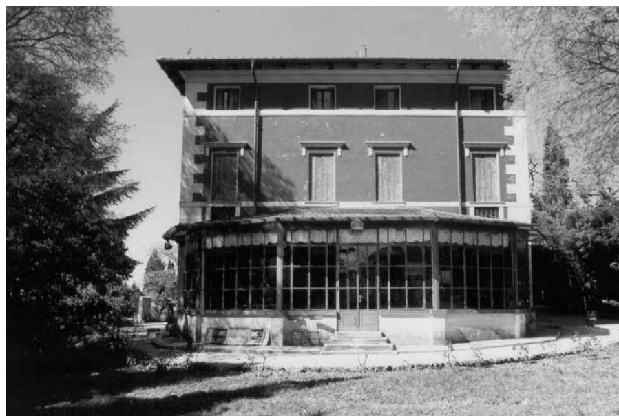
Vista della veranda vetrata (Archivio IRVV)
