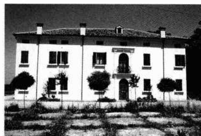
Il complesso edificato visto da sud-ovest (R.M. 1989)
