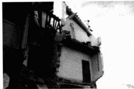
Il salone interno Particolare del fronte meridionale dopo l'alluvione Veduta del lato nord-occidentale Particolare dello sventramento causato dall'alluvione
