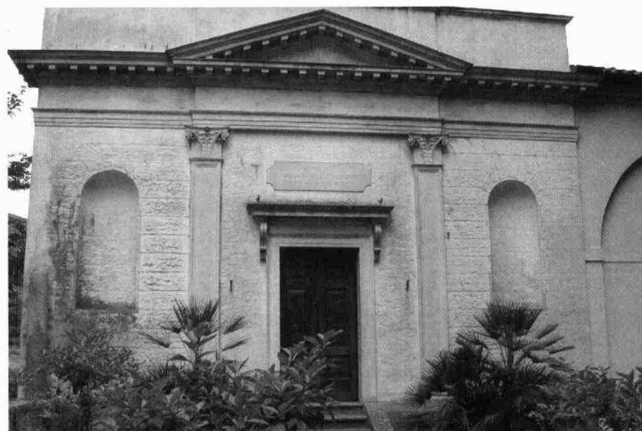
Il fronte della cappella
