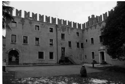
Prospetto occidentale con a destra l'abside poligonale della cappella (C.B.)
