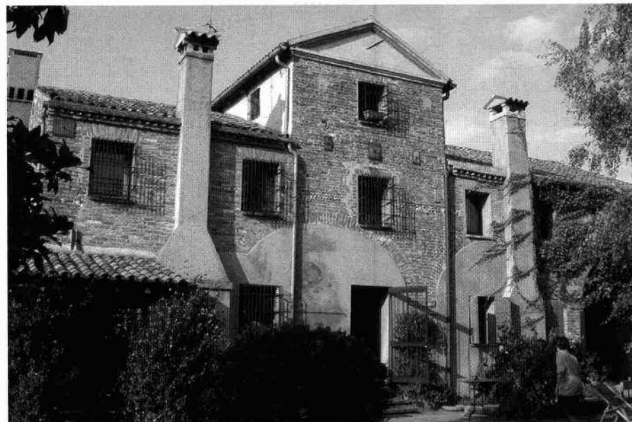
La facciata con l'androne d'ingresso laterale La facciata interna della villa verso il giardino
