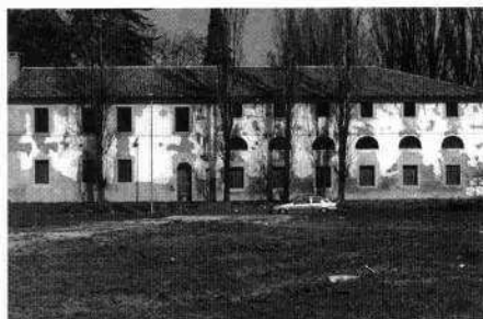
Particolari degli affreschi di C. Cedini raffiguranti "Le Muse" e "Venere e Vulcano" Il fronte della barchessa sulla strada dopo i lavori di restauro Particolare degli annessi prima dei lavori di restauro
