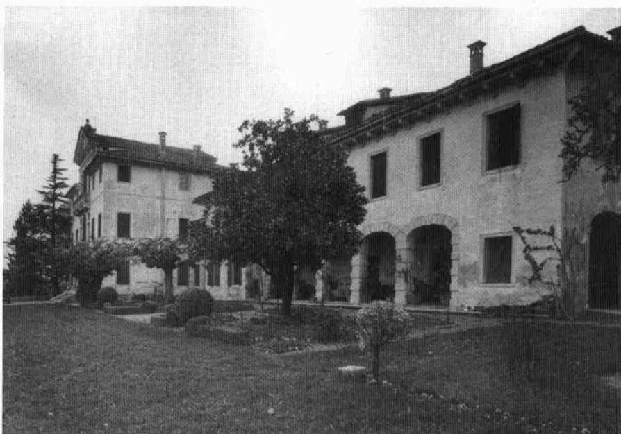
Fronte sud del corpo padronale: particolare del settore centrale (Archivio IRVV, 1972)
